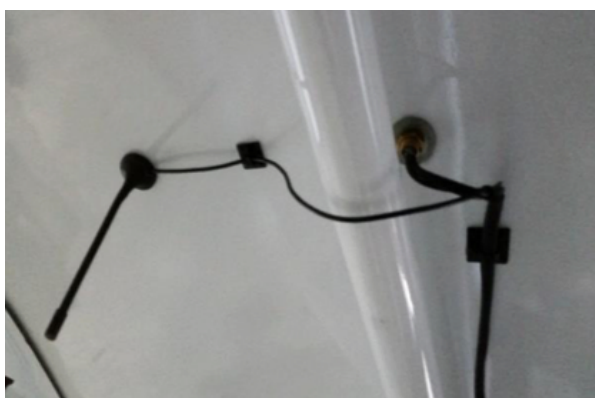
Bild 14: Montage WIFI-Antenne Dach-innenseite
